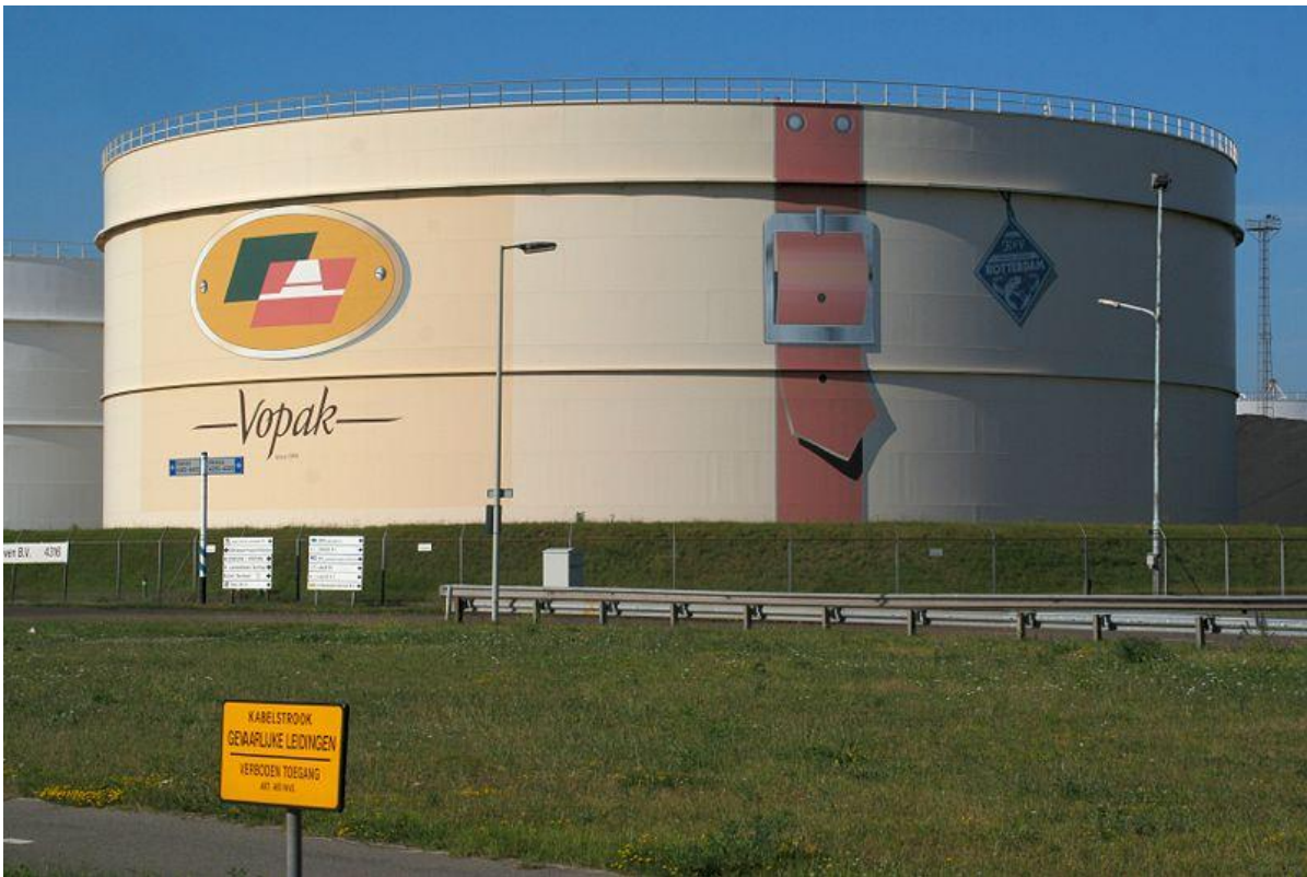
figuur 22: Een opvallende olieopslagtank in de Botlek (bron: Wikipedia).
